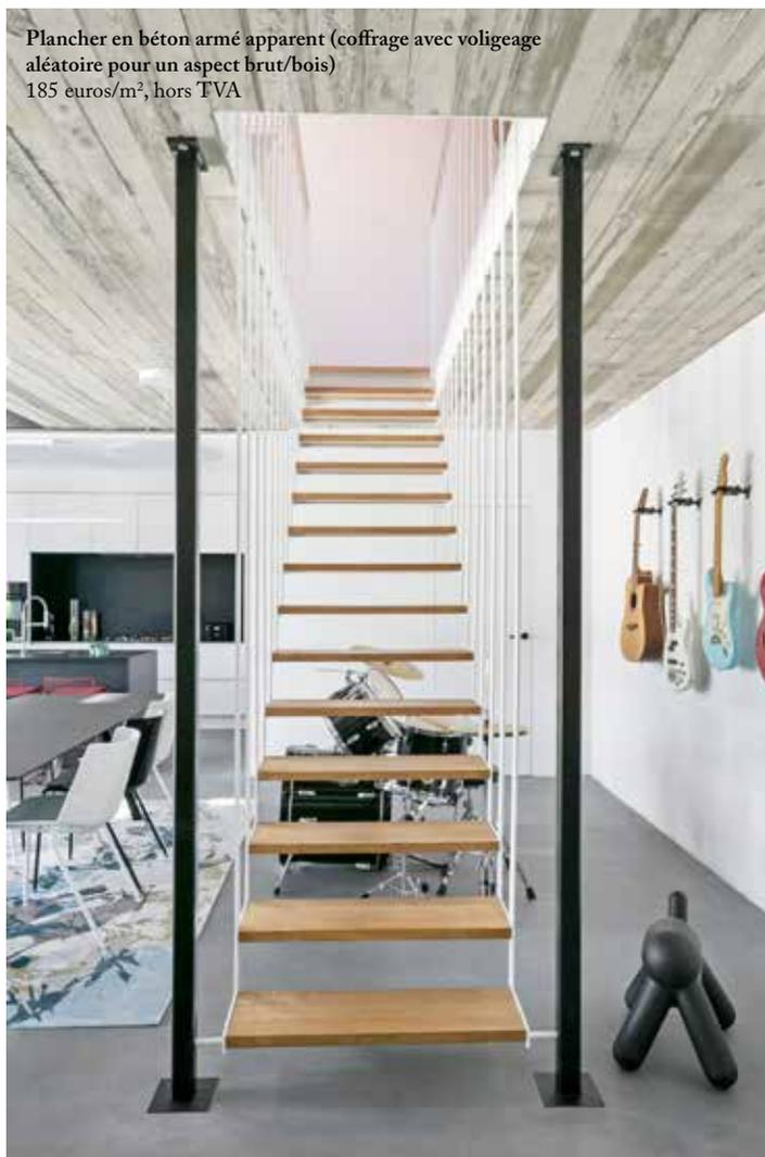
Plancher en béton armé apparent (coffrage avec voligeage aléatoire pour un aspect brut/bois)
