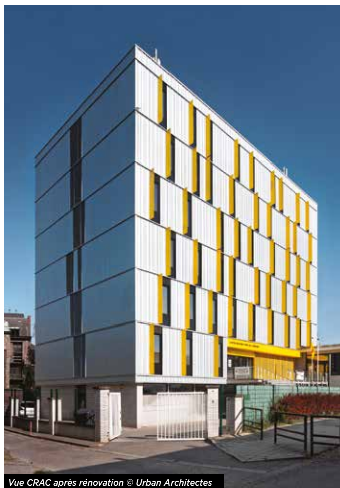
Vue CRAC après rénovation © Urban Architectes
