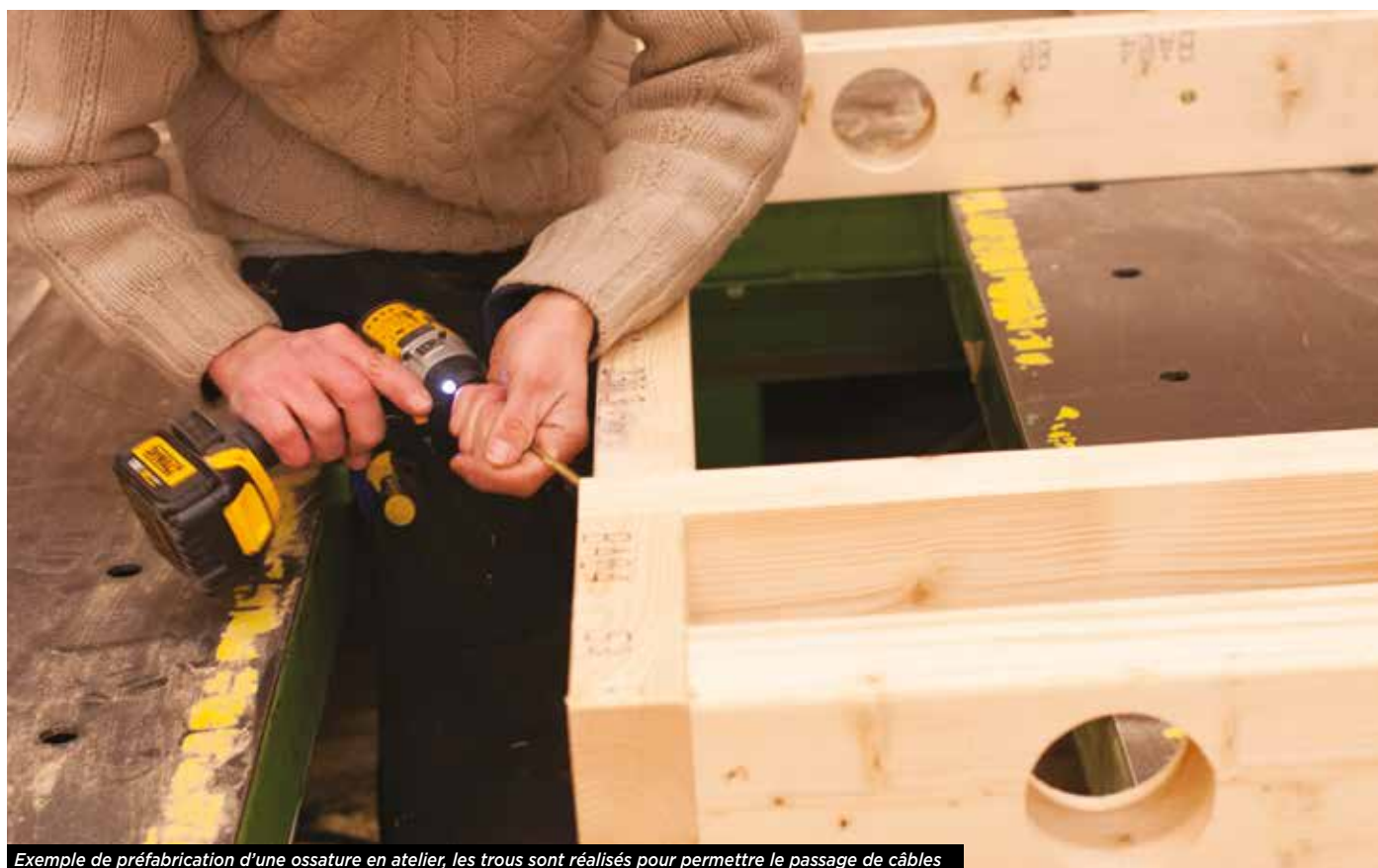
Exemple de préfabrication d'une ossature en atelier, les trous sont réalisés pour permettre le passage de câbles
