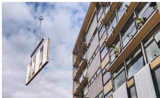
Rénovation du CRAC pose des éléments préfabriqués © Urban Architectes
